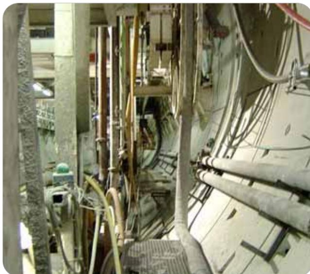
ecobus power 5G2.5mm<sup>2</sup> (hellgrün) an der rechten Tunnelwand provisorisch verlegt für Baubeleuchtung
